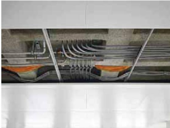
Außerdem wurden auf einer Gesamtfläche von 5.600 Quadratmetern Heiz-Kühldecken verbaut. Dabei handelt es sich um Klimadecken aus gelochten Metallplatten, die Strahlungswärme abgeben. Die meisten Menschen empfinden diese Wärmeform am angenehmsten. An heißen Sommertagen kühlt die Klimadecke und bietet ein gutes Raumklima. Weiterer Vorteil der Heiz-Kühldecken: Sie absorbieren den Schall und tragen damit zum konzentrierten Arbeiten bei.
