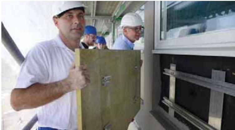
Bei der Außendämmung sorgt ein 14 Zentimeter starkes Wärmedämm-Verbundsystem aus nicht brennbarer Mineralwolle für gute energetische Werte und einen künftig niedrigeren Energieverbrauch.
